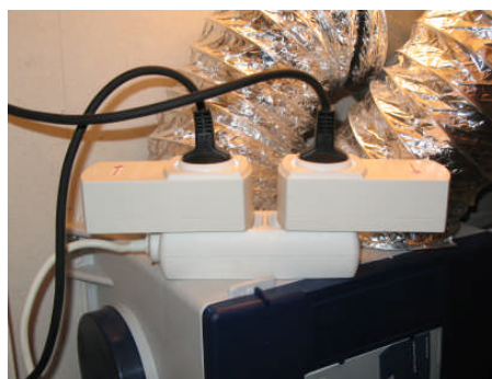
Fig.5. De stroomkabels vervoeren de geleverde stroom naar het net. De 'Dirty power' component wordt efficiënt weggefilterd door de bijgeschakelde Stetzerfilters.
